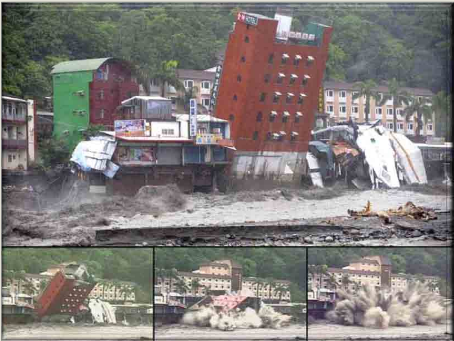
ภาพขณะตึกกำลังถล่มจากน้ำไหลบ่าอย่างแรงเกิดที่ประเทศไต้หวัน
