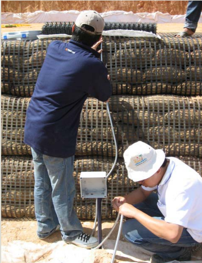
การติดตั้ง Geodetect
