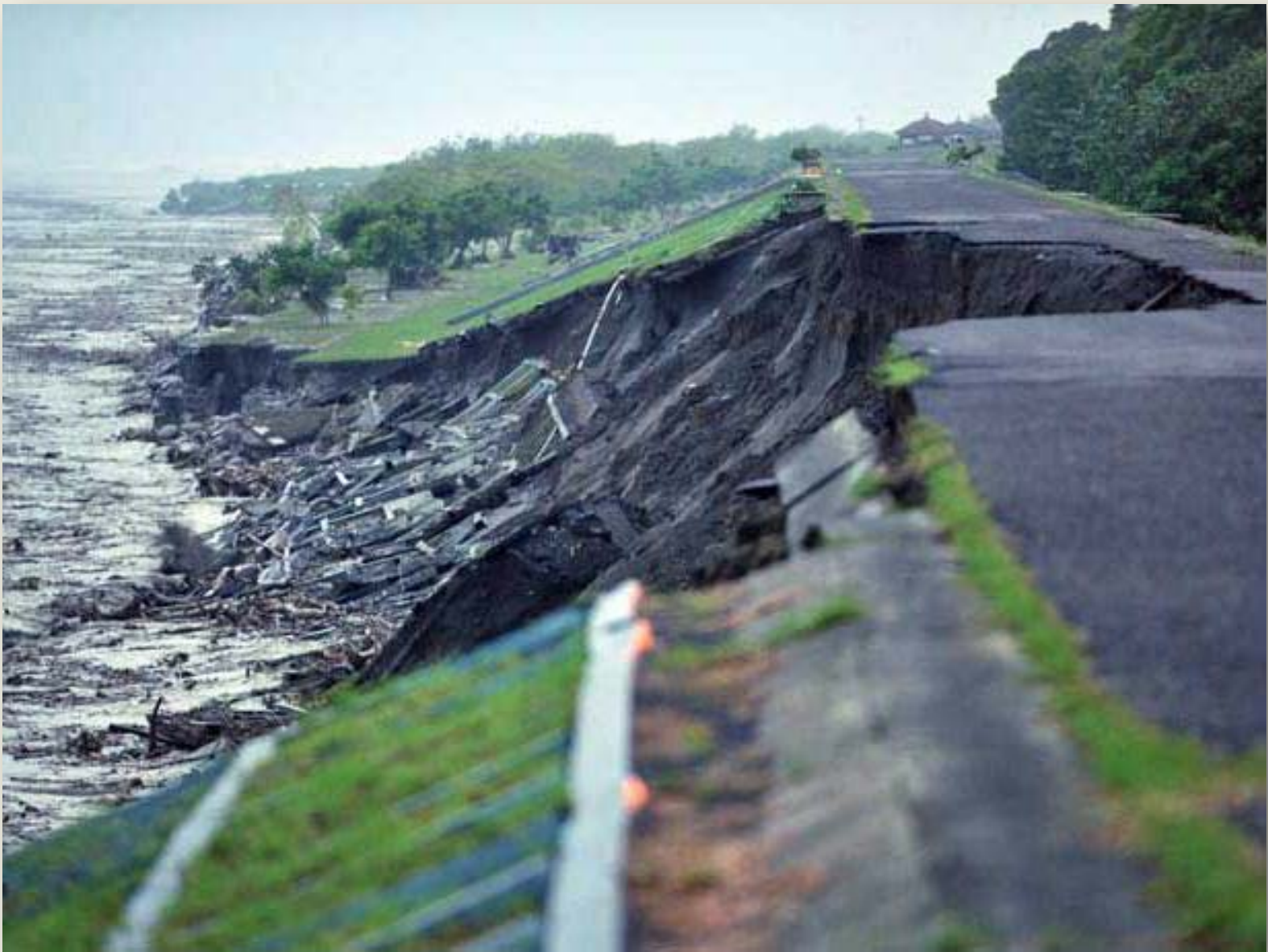
ถนนสไลด์เนื่องจากน้ำไหลบ่ามากัดเซาะคันทางที่ประเทศไต้หวัน
